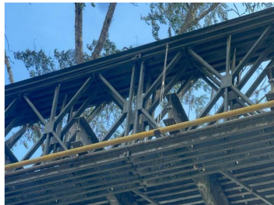
Figura No 12. Redes en cercanía con la estructura Fuente. Propia, 2025
