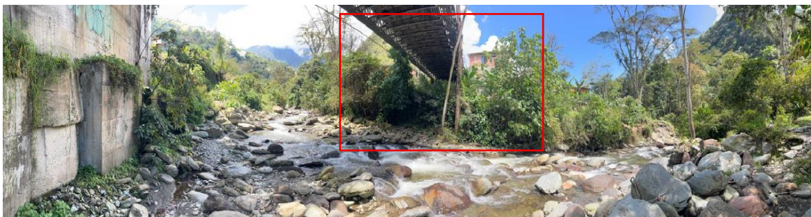
Figuras 5, 6 y 7. Aspecto del estribo Noreste del puente modular de la vereda Pastales, Ibagué. Fuente. Propia, 2025
