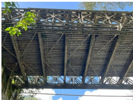
Figuras No 8. Aspecto de riostras y diagonales Fuente. Propia, 2025
