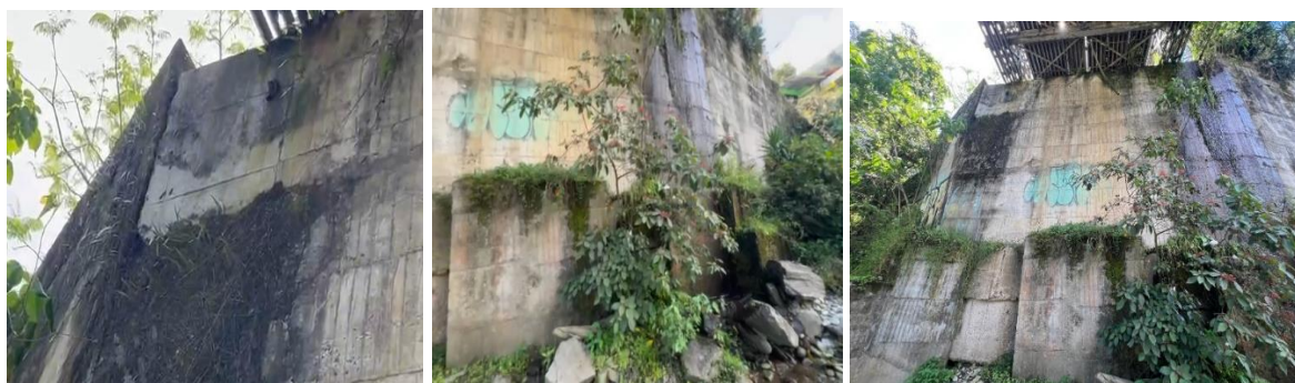
Figuras 2, 3 y 4. Aspecto del estribo Noroeste del puente modular de la vereda Pastales, Ibagué. Fuente. Propia.
