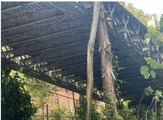
Figura No 11. Vegetación sobre la estructura Fuente. Propia, 2025
